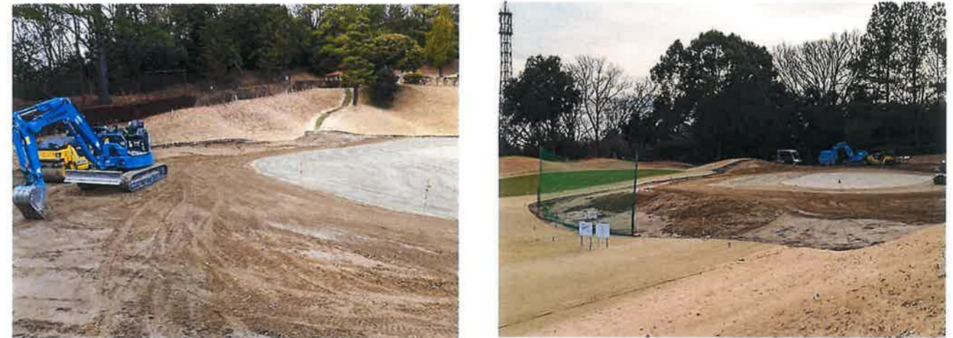
◎6番ホール右グリーン全面改修工事 令和5年7月完成
