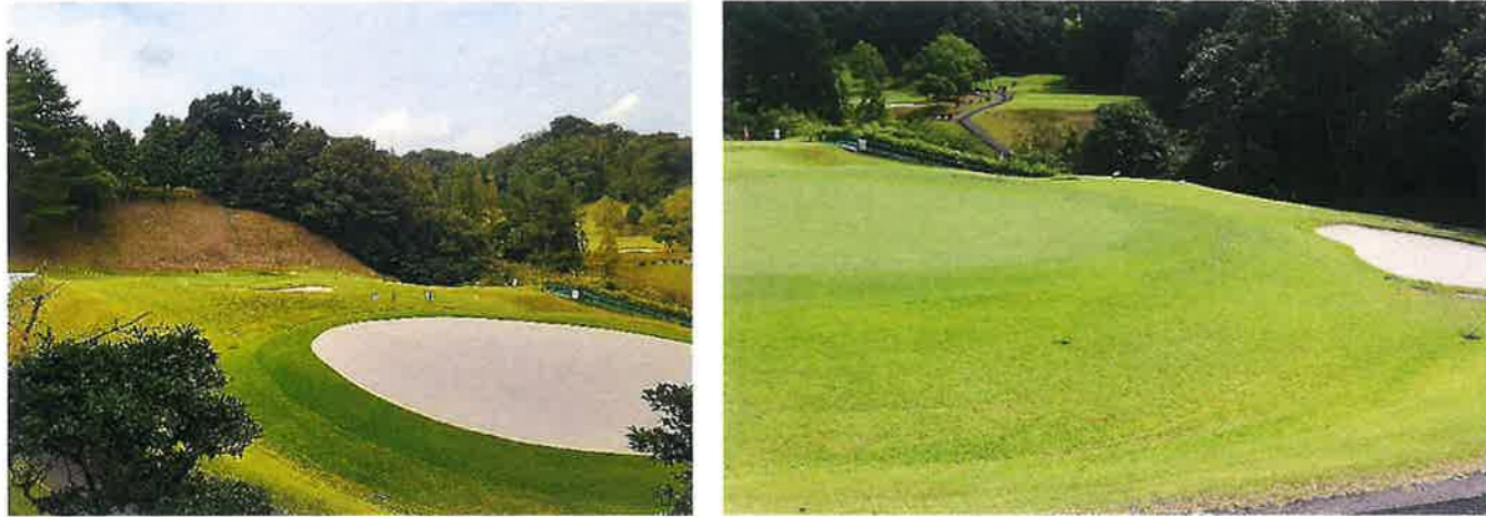
◎16番ホール左グリーン全面改修工事
