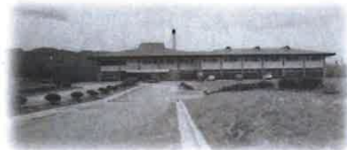
コース完成時のクラブハウス
